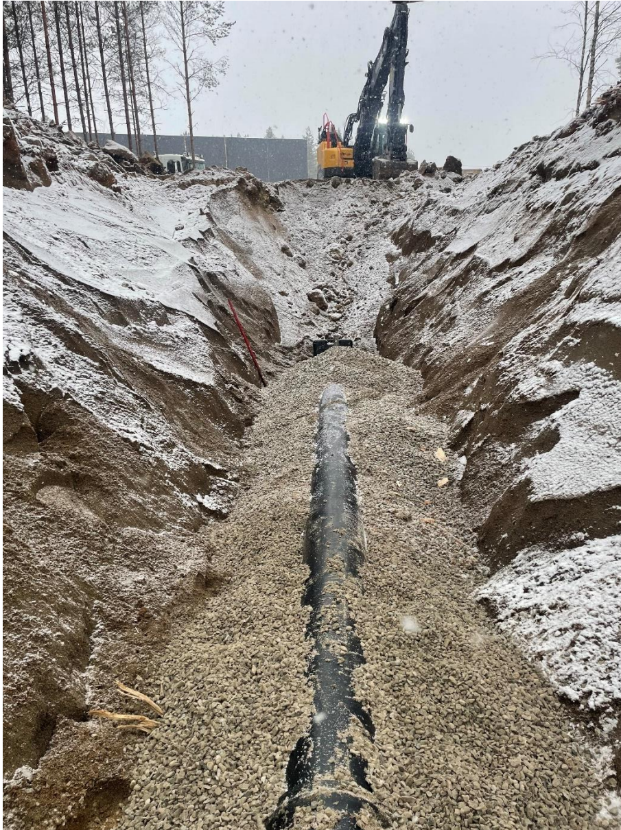
Bilde 4: Graving på parsell 3A
